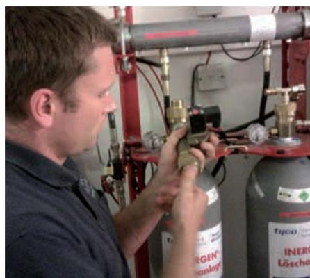
Überprüfung der Gaslöschanlagen in den Serverräumen des Innsbrucker Rathauses durch die Berufsfeuerwehr
