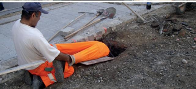
Im Zuge von Oberflächenenerneuerungen werden im Vorfeld – aufgrund der erreichten maximalen Lebensdauer – meist die Ver- und Entsorgungsleitungen (z. B. für Wasser, Strom, Abwasser etc.) getauscht.
