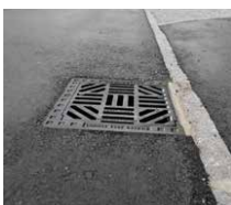
Einlaufgitter AUSTRIA TOP für stark beanspruchte Straßen im städtischen und innerörtlichen Bereich.
