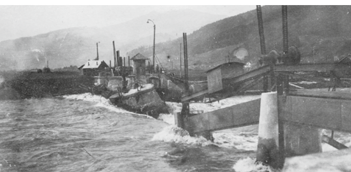
Unterspülte Pfeiler und eingestürzte mechanische Klappenwehr im Mai 1925
