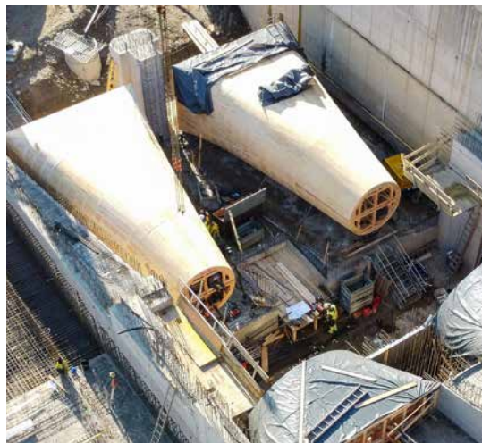
Saugrohrschalung beim Wehrkraftwerk
