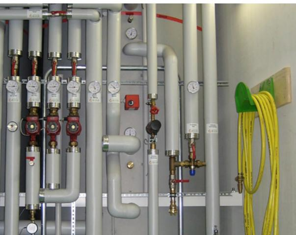
Mit hochwertigen Dämmstoffen schützen wir Heiz- und Kühl anlagen vor Energieverlust, Korrosion und Kondensat schäden. Gerade im Bereich Kälte dämmung ist der richtige Materialeinsatz essenziell, um Feuchtigkeitseintritt und langfristige Schäden zu vermeiden. Auch ungedämmte Rohrleitungen oder Armaturen werden von uns fachgerecht nachgerüstet – effizient und langlebig.
