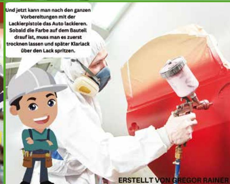
Und jetzt kann man nach den ganzen Vorbereitungen mit der Lackierpistole das Auto lackieren. Sobald die Farbe auf dem Bauteil drauf ist, muss man es zuerst trocknen lassen und später Klarlack über den Lack spritzen.
